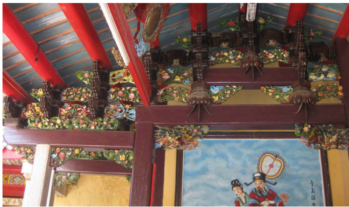
Picture 5: Style of “trính chống-trụ đội” beams in Teochius huiguan
